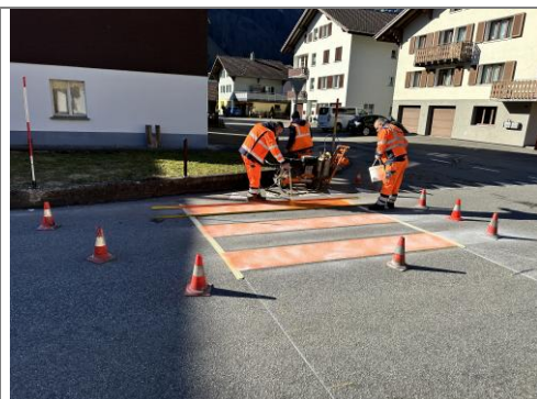
27.02.2026 / Marktstrasse – Markierung prov. Fussgänger
