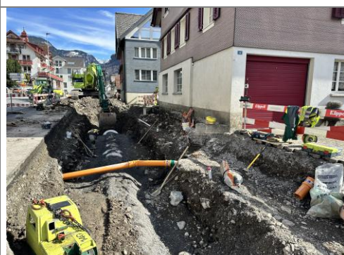
11.03.2026 / Wegscheid – Verlegen Meteorleitung inkl. Grabenaufb.
