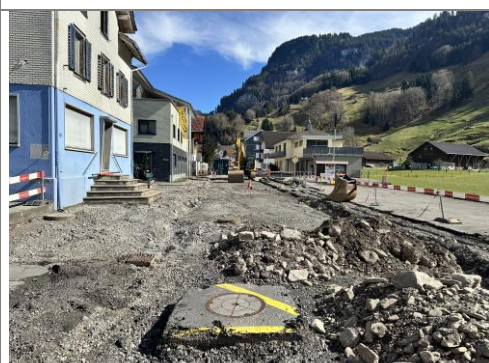
13.03.2026 / Klosterstrasse – diverse Abbrucharbeiten
