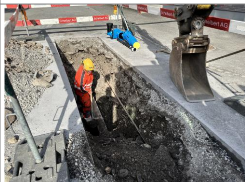
09.03.2026 / Klosterstrasse – Aushub Anschluss Trinkwasserleitung
