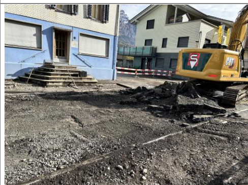
11.03.2026 / Klosterstrasse – diverse Abbrucharbeiten
