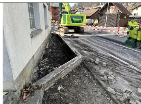
09.03.2026 / Wegscheid – diverse Abbrucharbeiten
