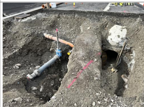
11.03.2026 / Wegscheid – Sondage Trinkwasser- und Meteorleitung
