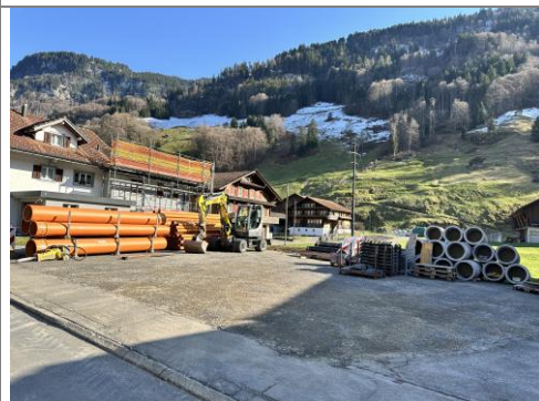
18.03.2026 / Klosterstrasse – Einrichtung Installationsplätze
