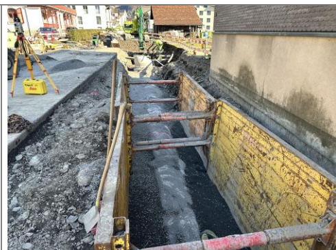
18.03.2026 / Wegscheid – Verlegen Meteorleitung in Spriessung
