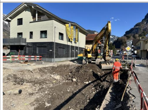
18.03.2026 / Klosterstrasse – Aushub Fundationsschicht
