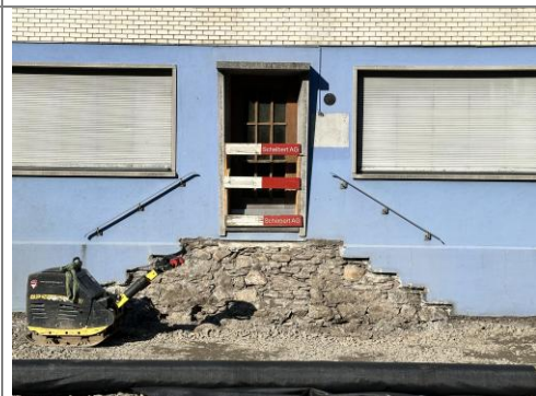
18.03.2026 / Klosterstrasse – Abbruch best. Treppe Rest. Sternen
