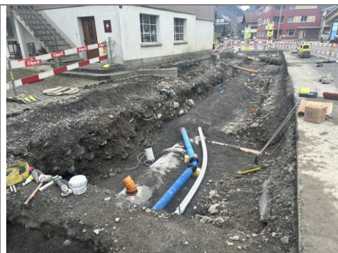
16.03.2026 / Wegscheid – Verlegen Werkleitungen inkl. Anschlüsse
