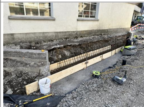
20.03.2026 / Wegscheid – Schalung & Bewehrung Mauer KTN 632
