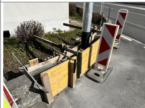
20.03.2026 / Wegscheid – Schalung Brüstungsmauer Gängstrasse
