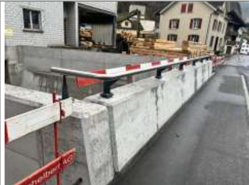
23.03.2026 / Hüribachbrücke – Montage Geländer oberwasserseitig
