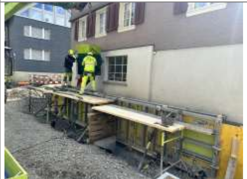
25.03.2026 / Wegscheid – Betonieren Umgebungsmauer KTN 632
