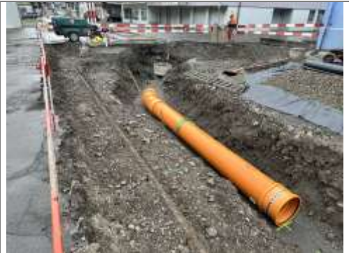
23.03.2026 / Klosterstrasse – prov. Anschluss Meteorleitung
