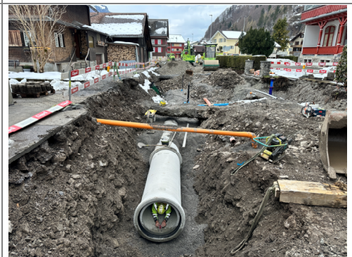
01.04.2026 / Wegscheid-Hundenengässli – Verlegen Meteorleitung
