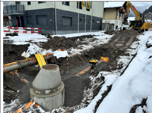
30.03.2026 / Klosterstrasse – Verlegen Meteorleitung inkl. Schächte
