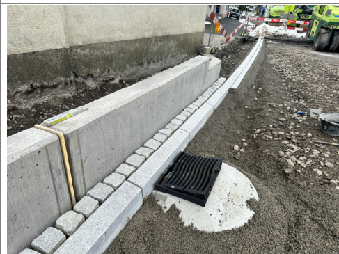
01.04.2026 / Wegscheid – Versetzen Randabschlüsse und Abdeckung
