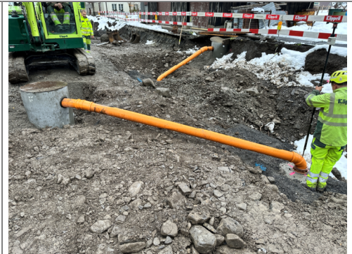
30.03.2026 / Wegscheid – Verlegen Schlammsammler und Ableitung
