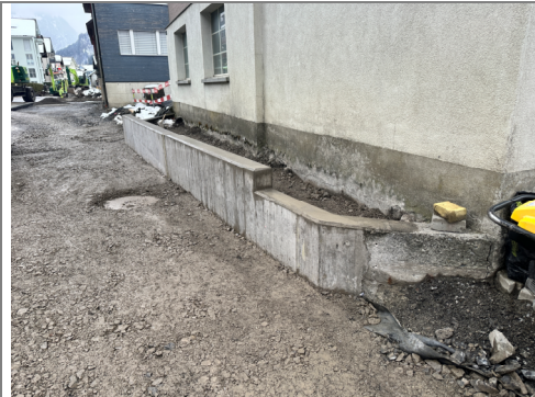
30.03.2026 / Wegscheid – Fertigstellung Umgebungsmauer KTN 632
