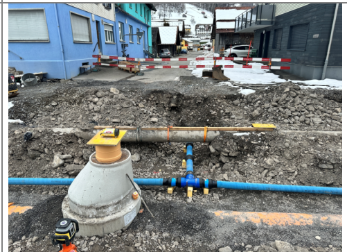
01.04.2026 / Klosterstrasse – Verlegen Trinkwasserleitung
