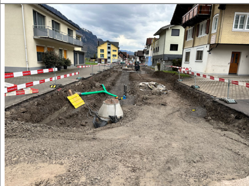
01.04.2026 / Wegscheidi – Versetzen Randabschlüsse und Abdeckung
