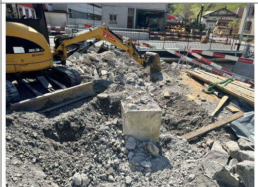
09.04.2026 / Hüribach – Rückbau Kranfundamente
