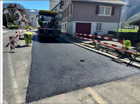
08.04.2026 / Wegscheidi – Einbau Trag- und Binderschicht
