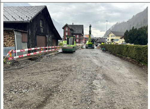
10.04.2026 / Wegscheidi-Hundengässli – Einbau Koffer
