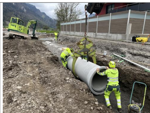
16.04.2025 / Weid – Verlegen Betonrohre Regenwasserleitung
