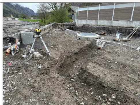
17.04.2025 / Weid – Versetzen Schlammstammler und Kontrollschacht
