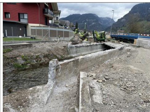
16.04.2025 / Bürgelibach – Abbruch bestehende Brückenplatte
