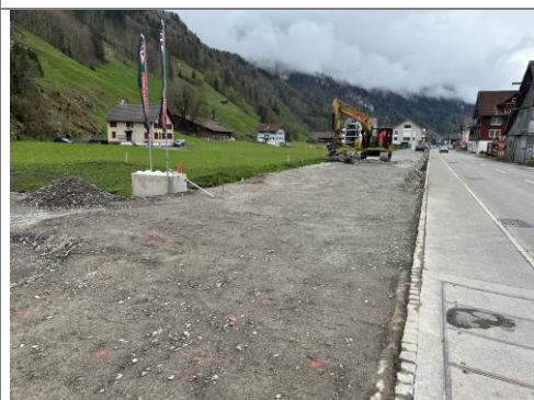
17.04.2025 / Adelmatt – Koffierung und Rohplanie prov. Trassee
