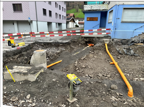
15.04.2026 / Klosterstrasse – Meteor- und Schmutzwasseranschlüsse
