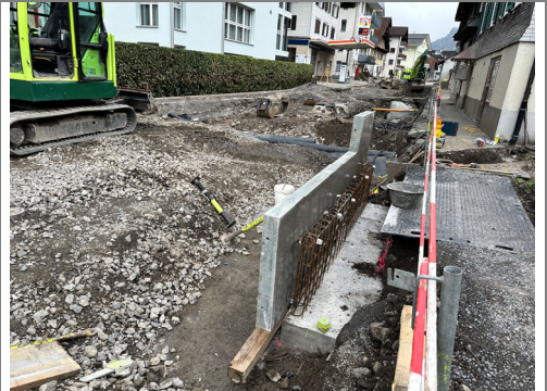
13.04.2026 / Wegscheid-Hundeneng. – Bewehrung Mauer KTN 636
