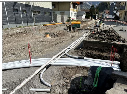
17.04.2026 / Klosterstrasse – Verlegen Kabelschutzrohre
