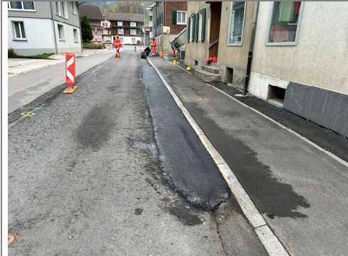
13.04.2026 / Bödeli – Belagsanrampungen / Baustelleneinrichtung
