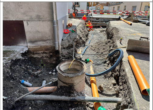
17.04.2026 / Bödeli – Verlegen Werkleitungen Privatanschlüsse
