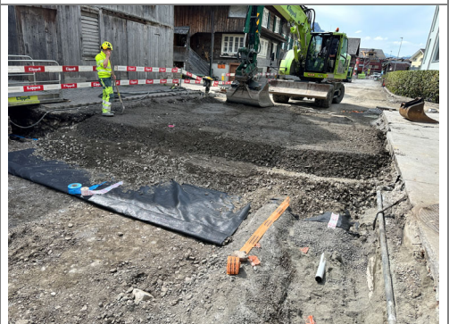
17.04.2026 / Wegscheid-Hundeneng. – Einbau Fundationsschicht
