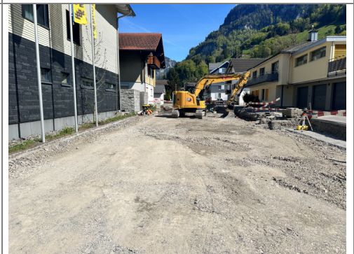
24.04.2026 / Klosterstrasse – Einbau Fundationsschicht
