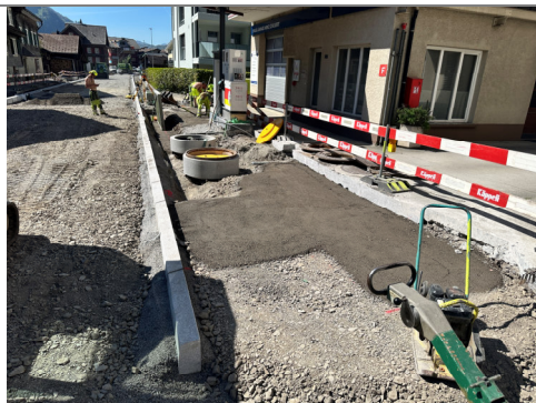
24.04.2026 / Wegscheid-Hundeneng. – Vorbereitung Betonplatte
