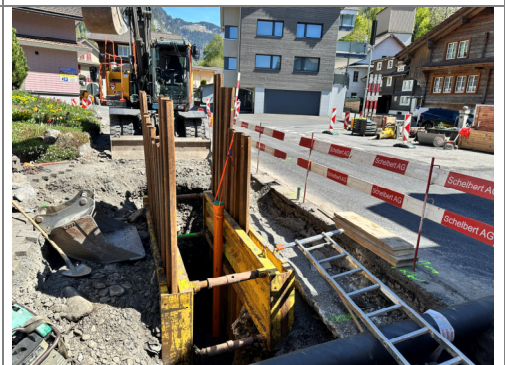
24.04.2026 / Bödeli – Schmutzwasseranschluss
