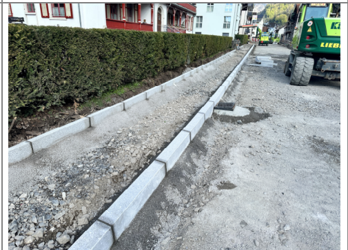
22.04.2026 / Wegscheid-Hundeneng. – Versetzen Randabschlüsse
