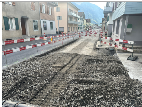
22.04.2026 / Bödeli – Einbau Fundationsschicht
