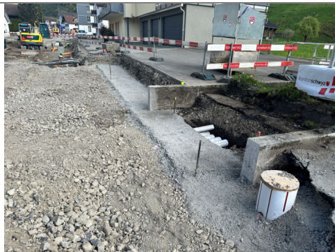
22.04.2026 / Klosterstrasse – Sauberkeitsschicht KTN 690
