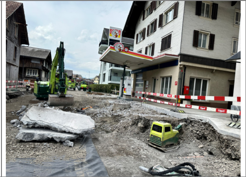
20.04.2026 / Wegscheid-Hundeneng. – Abbruch Betonplatte
