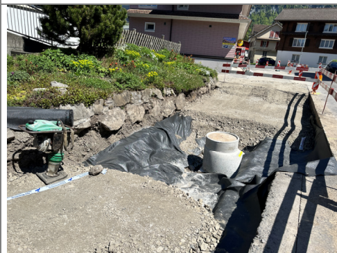
01.05.2026 / Bödeli – Vlies verlegen / Einbau Koffer
