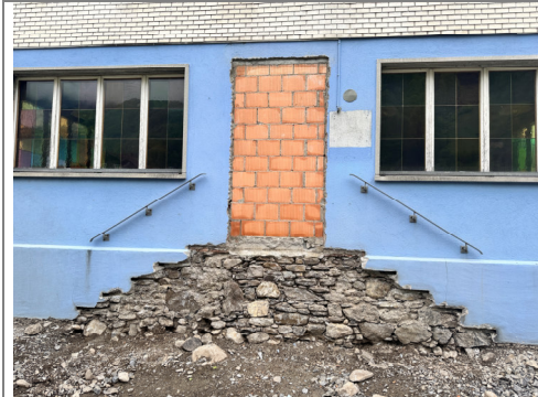
29.04.2026 / Klosterstrasse – Zumauern Eingangstür Rest. Sternen
