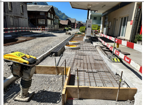
01.05.2026 / Wegscheid-Hundeneng. – Vorbereitung Betonplatte
