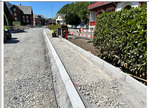
01.05.2026 / Wegscheid-Hundeneng. – Rohplanie Trottoir
