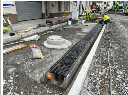
29.04.2026 / Wegscheid-Hundenen. – Versetzen Entwässerungsrinne
