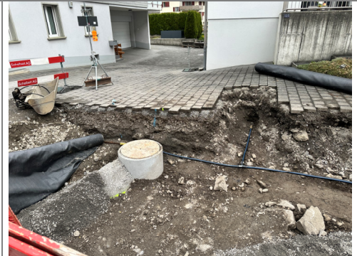
29.04.2026 / Bödeli – Erstellen Trinkwasseranschlüsse
