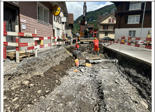
07.05.2026 / Bödeli – Trasseeaushub / Vorarbeiten Werkleitungsbau
