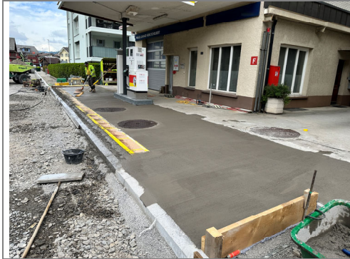
05.05.2026 / Wegscheid-Hundeneng. – Betonieren Vorplatz Tankstelle
