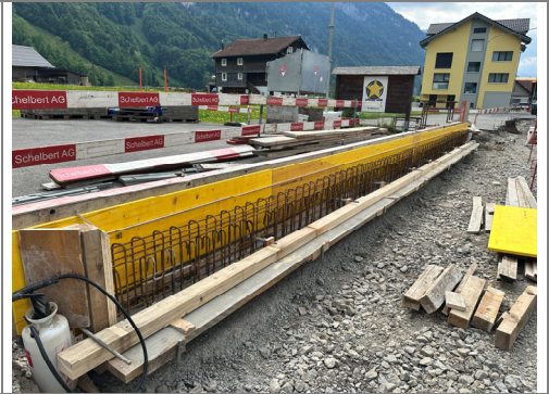
05.05.2026 / Klosterstrasse – Schalung/Bewehrung Mauer KTN 690
