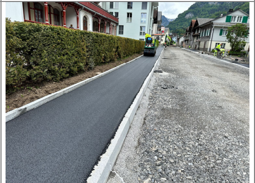
07.05.2026 / Wegscheid-Hundeneng. – Einbau Deckbelag Trottoir
