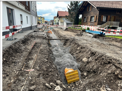
05.05.2026 / Klosterstrasse – Verlegen Meteorleitung
