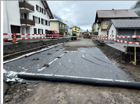
12.05.2026 / Klosterstrasse – Verlegen Geotextil / Einbau Koffer
