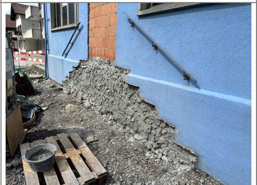
13.05.2026 / Klosterstrasse – Vorbereitung Hausfassade Sternen
