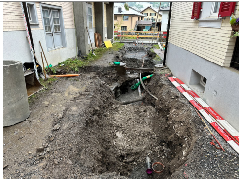
12.05.2026 / Bödeli – Erstellen Privatan schlüsse Werkleitungsbau
