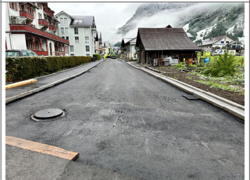
12.05.2026 / Wegscheid-Hundeneng. – Einbau Trag- u. Binderschicht
