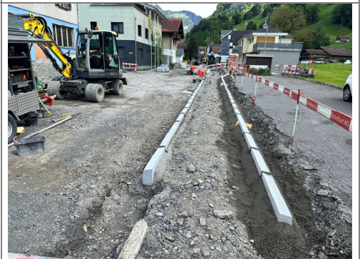
13.05.2026 / Klosterstrasse – Versetzen von Randabschlüssen
