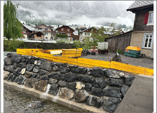
12.05.2026 / Hüribach – Abschalung Mauerkrone Dammschluss
