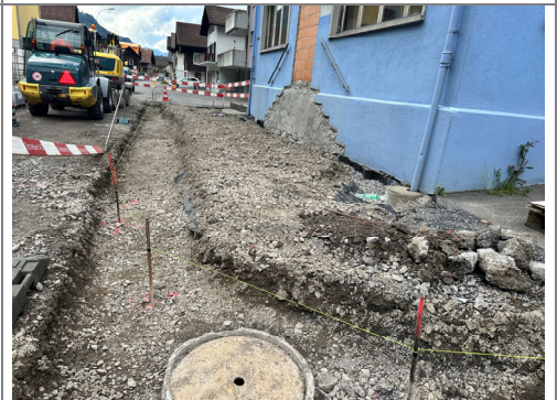
20.05.2026 / Klosterstrasse – Aushub und Abstreckung Randabschluss
