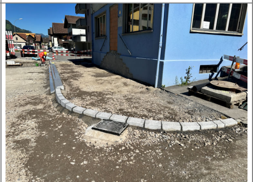
21.05.2026 / Klosterstrasse – Versetzen von Randabschlüssen
