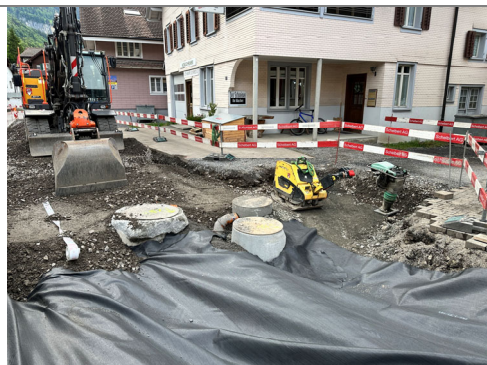
20.05.2026 / Bödeli – Geotextil / Einbau Fundationsschicht
