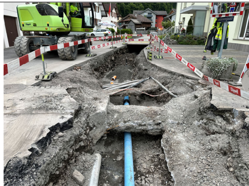
19.05.2026 / Hundenengässli – Erschliessung Trink- u. Meteorleitung
