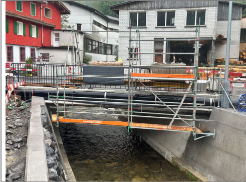
18.05.2026 / Hürbachbrücke – Gerüst Montage Rohrabdeckung
