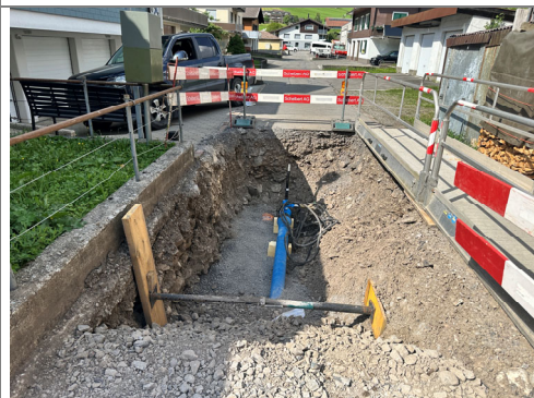
27.05.2026 / Wehrstrasse – Trinkwasseranschluss
