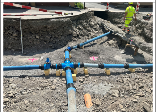
28.05.2026 / Knoten Goldplanggstrasse – Verlegen Trinkwasserleitung
