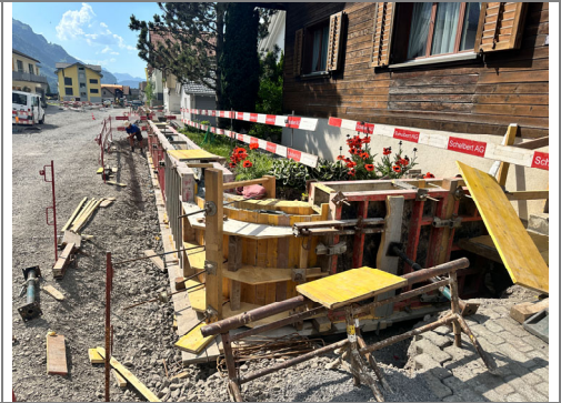
27.05.2026 / Klosterstrasse – Schalung Umgebungsmauer KTN 1018
