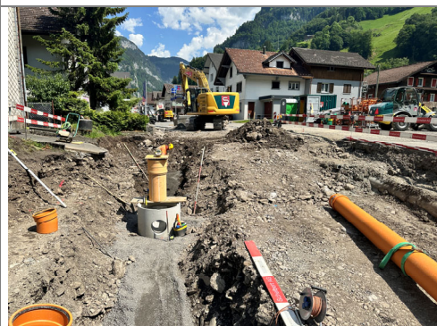
28.05.2026 / Wehrstrasse – Werkleitungsbau (Schmutzwasserleitung)
