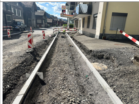
11.06.2026 / Goldplangstrasse – Versetzen Randabschlüsse
