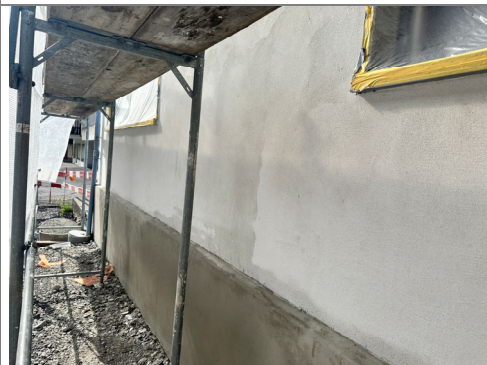
11.06.2026 / Klosterstrasse – Sanierung Fassade Restaurant Sternen
