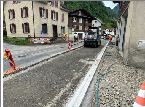
08.06.2026 / Bödeli – Einbau Feinplanie
