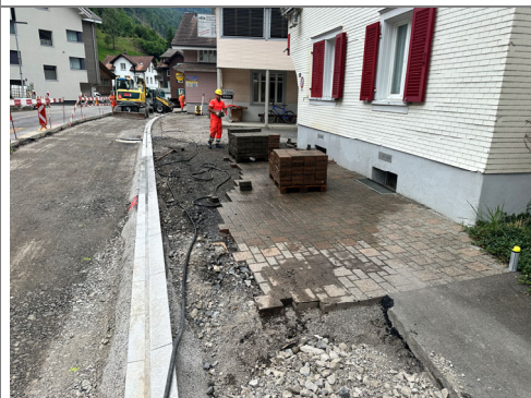
08.06.2026 / Bödeli – Anpassungsarbeiten Vorplätze
