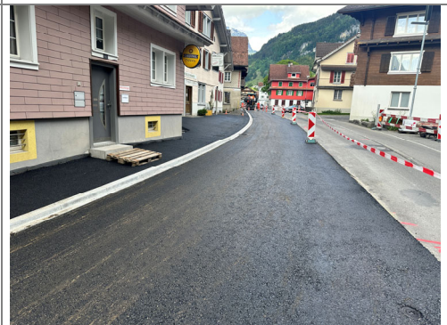
11.06.2026 / Bödeli – Einbau Trag- und Binderschicht Fahrbahn
