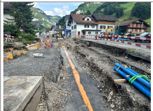
11.06.2026 / Wehri- bis Denkmalstrasse – Verlegen Meteorleitung
