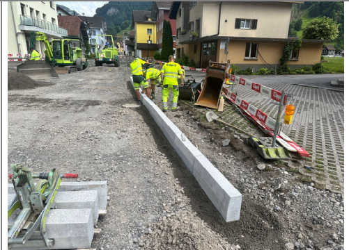
08.06.2026 / Goldplangstrasse – Versetzen Randsteine
