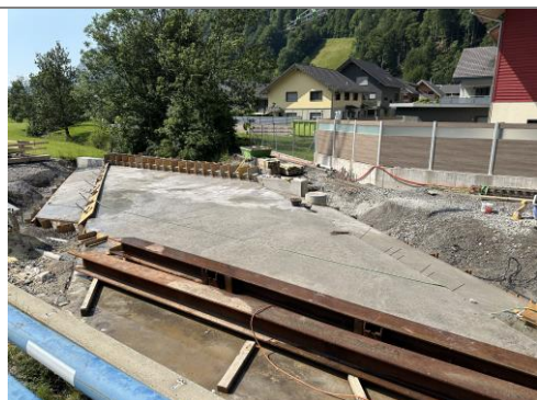
18.06.2025 / Bürgelibach – Betonierte Brückenplatte
