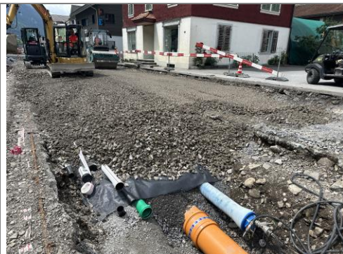
16.06.2025 / Adelmatt – Werkleitungsbau / Einbau Koffer
