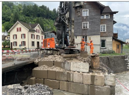
16.06.2025 / Hüribach – Erstellen Ortsbetonpfähle Wasserbau
