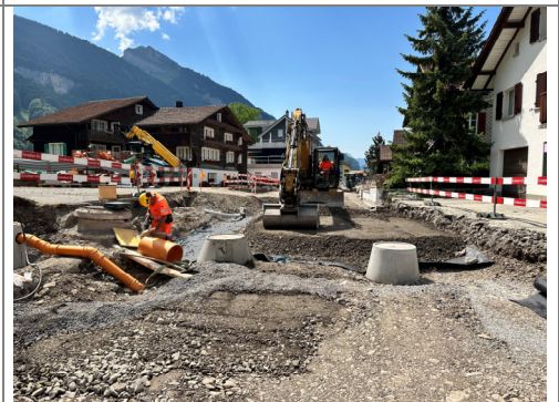
19.06.2026 / Wehri-Denkmalstr. – Einbau Koffer / Leitungsanschlüsse
