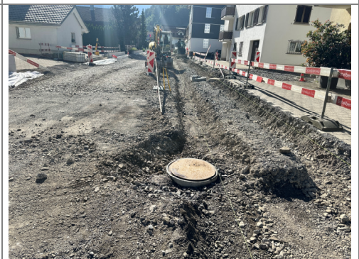
17.06.2026 / Wehri-Denkmalstr. – Aushub & Absteckung Randsteine
