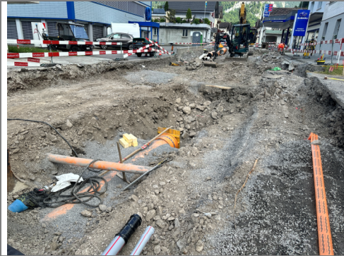
15.06.2026 / Wehri- bis Denkmalstrasse – Verlegen Meteorleitung
