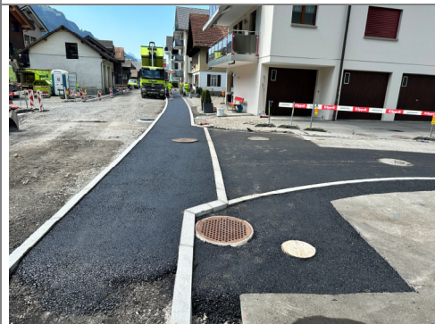
19.06.2026 / Hundengässli – Belageinbau Trottoir & Vorplätze
