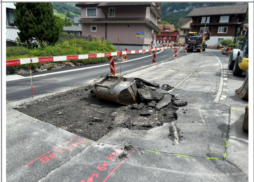
16.06.2026 / Bödeli – Beginn Abbruch Fahrspur Hinterthal
