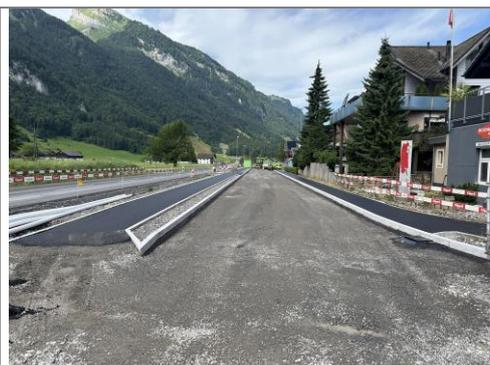
26.06.2025 / Weid – Einbau Tragschicht Trottoir / Feinplanie Fahrbahn
