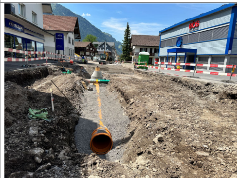
26.06.2026 / Wehri-Denkmalstr. – Werkleitungsbau Meteorleitung
