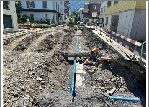
24.06.2026 / Hundenengässli-Brämis – Verlegen Trinkwasserleitung
