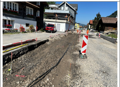
24.06.2026 / Wehri-Denkmalstr. – Aushub & Absteckung Randsteine
