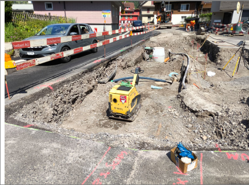
22.06.2026 / Bödeli – Werkleitungsbau / Belagsabbrüche
