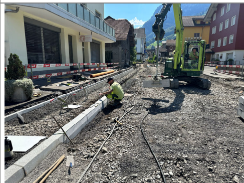
24.06.2026 / Hundenengässli-Brämis – Versetzen Randabschlüsse
