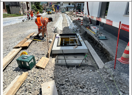
26.06.2026 / Kloster-Wehrstr. – Anpassung Swisscom-Schacht
