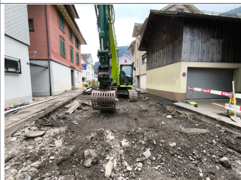
03.07.2026 / Hundenengässli-Brämis – Abbruch Belag
