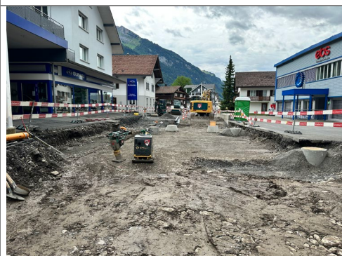
01.07.2026 / Wehri-Denkmalstr. – Einbau Koffer / Erstellen Rohplanie
