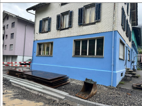
01.07.2026 / Klosterstrasse – Malen Fassade / Demontage Gerüst
