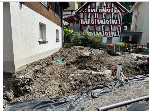
30.06.2026 / Bödeli – Abbruch best. Umgebungsmauer
