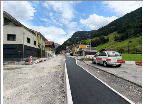
06.07.2026 / Kloster-Wehistr. – Einbau Belag Gehweg
