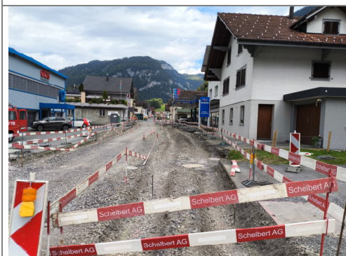
08.07.2026 / Wehri-Denkmalstr. – Aushub & Absteckung Randsteine
