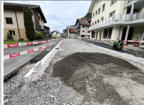
06.07.2026 / Hundenengässli-Brämis – Einbau Belag Gehweg
