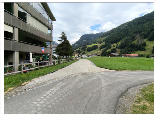
08.07.2026 / Brämis – Erstellen temp. Erschliessung Schachenmattli
