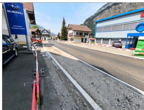
14.07.2026 / Kloster-Denkmalstr. – Einbau Tragschicht Fahrbahn
