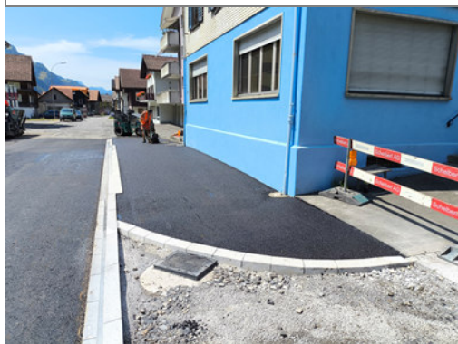
16.07.2026 / Klosterstrasse – Einbau Belag
