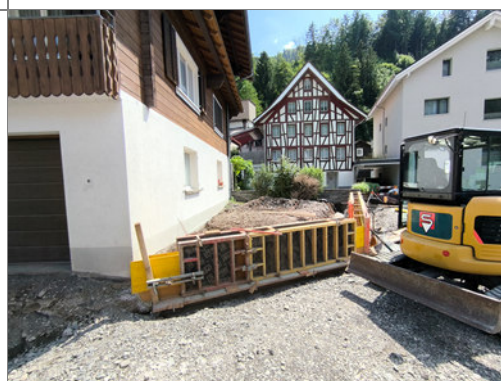
16.07.2026 / Bödeli – Schalung Wände / Bew. Umgebungsmauer
