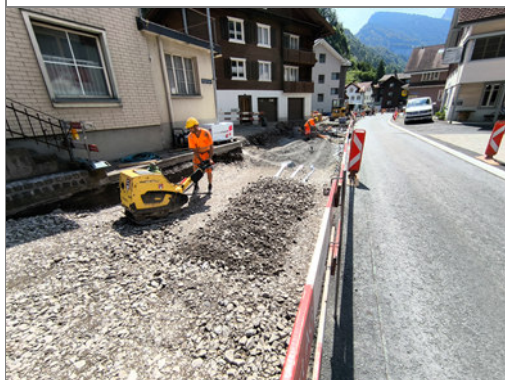
16.07.2026 / Bödeli – Einbau Koffer / Erstellen Rohplanie
