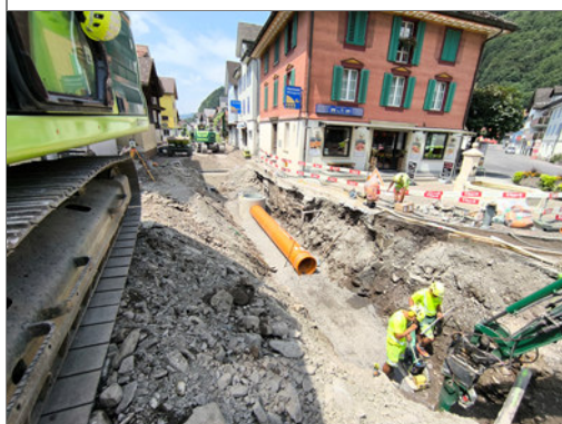
14.07.2026 / Brämis-Poststrasse – Aushub & Werkleitungsbau
