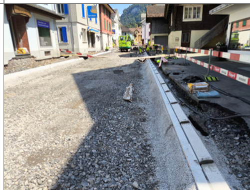
16.07.2026 / Hundenengässli-Brämis – Randabschlüsse inkl. Ausfugen
