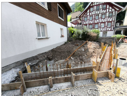
14.07.2026 / Bödeli – Schalung Fund. / Bewehrung Umgebungsmauer
