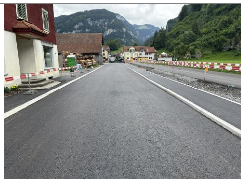
23.07.2025 / Adelmatt – Einbau Binderschicht
