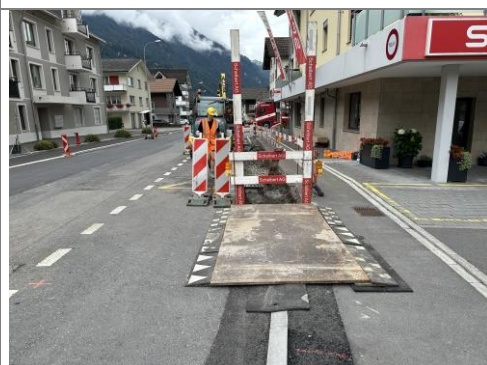
25.07.2025 / Adelmatt BHS Säge – Abbruch Randsteine
