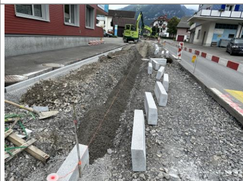
23.07.2025 / Weid-Wegscheide – Versetzen Randabschlüsse
