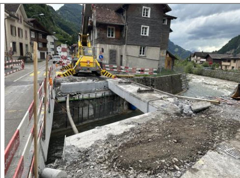
21.07.2025 / Hüribach– Abbruch Brückenplatte und Widerlager
