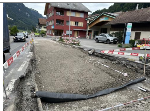
23.07.2025 / Weid-Wegscheide – Einbau Fundationsschicht (Koffer)
