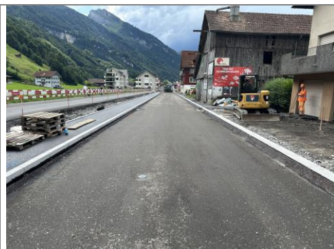
21.07.2025 / Adelmatt – Einbau Planie und Anstrich Randabschlüsse
