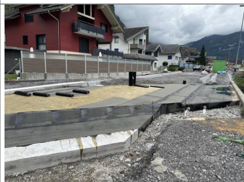
25.07.2025 / Bürgelbach – Hessensiegel und Beginn PBD-Abdichtung
