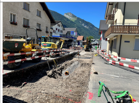
24.07.2026 / Wehri-Denkmalstrasse – Werkleitungsbau SWL
