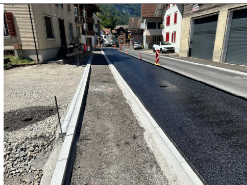
24.07.2026 / Bödeli – Einbau Trag- und Binderschicht FR Hinterthal
