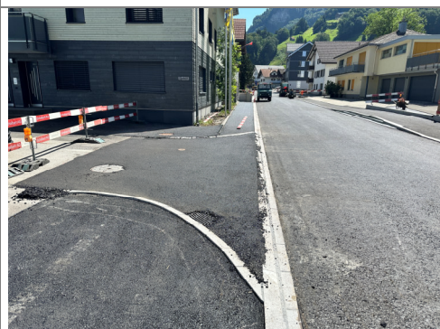
22.07.2026 / Klosterstrasse – Einbau Belag Einlenker Klosterstrasse
