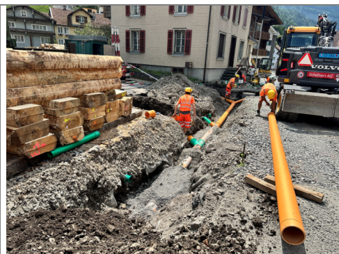
20.07.2026 / Bödeli – Verlegen Meteorwasserleitungen
