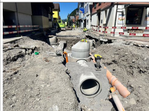
24.07.2026 / Brämis – Werkleitungsbau (Meteoerleitung)
