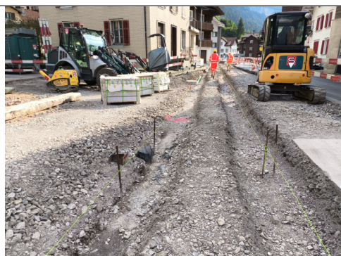
21.07.2026 / Bödeli – Absteckung Randabschlüsse
