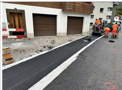
27.07.2026 / Bodeli – Einbau Tragschicht und Deckbelag Trottoir
