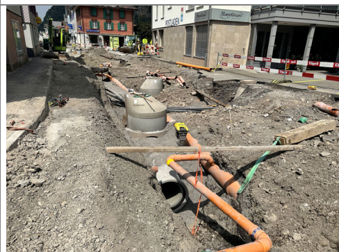
31.07.2026 / Brämis – Werkleitungsbau (Schmutz- u. Meteorleitung)
