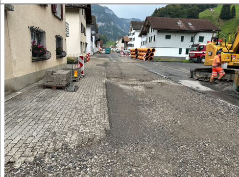
31.07.2026 / Denkmal-Marktrasse – Auffüllungen Werkleitungsbau
