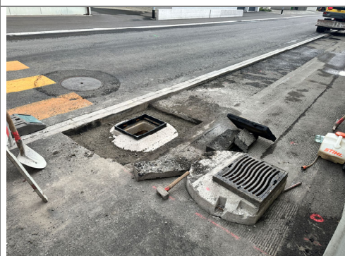
31.07.2026 / Bodeli – Vorbereitung Deckbelagseinbau Vorplätze
