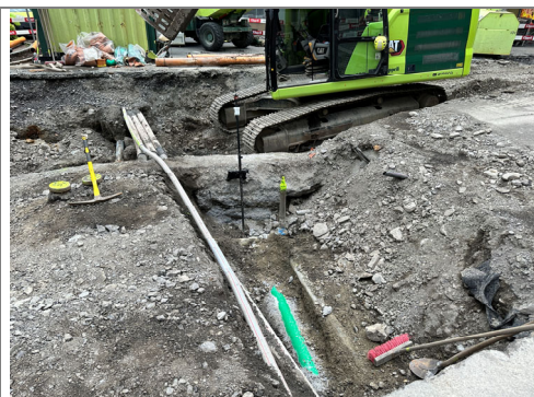
27.07.2026 / Brämis – Sondagen bestehende Werkleitungen
