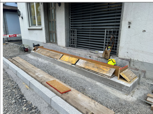
31.07.2026 / Goldplangg-Brämis – Erstellen Treppeneingang
