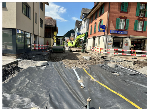
04.08.2026 / -Goldplanggstr.-Brämis – Einbau Koffer / Verlegen Vlies
