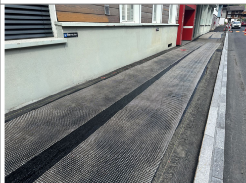
05.08.2026 / Küchenfabrik – Vorbereitung Belageinbau
