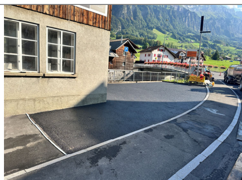
07.08.2026 / Bödeli – Einbau Tragschicht und Deckbelag PP H. Brücke
