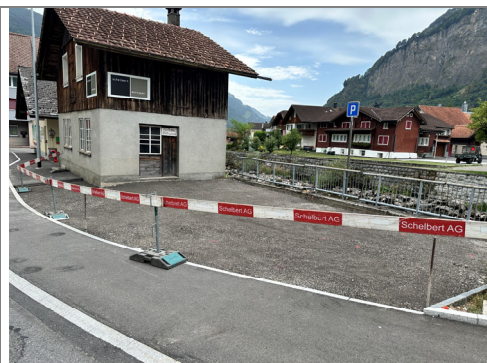
04.08.2026 / Bödeli – Feinplanie Parkplatz Hintere Brücke
