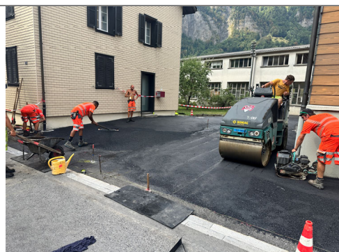
05.08.2026 / Küchenfabrik – Einbau Tragschicht u. Deckbelag
