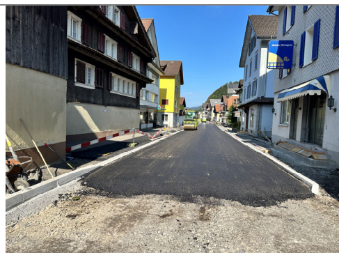
07.08.2026 / Wehri-Denkmalstr. – Einbau Trag- und Binderschicht
