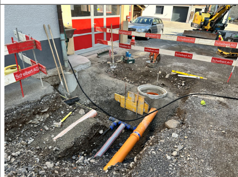
07.08.2026 / Wehri-Denkmalstr. – Werkleitungsbau Dritter
