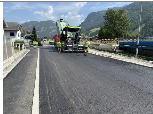
14.08.2025 / Bürgelibach – Einbau Trag- und Binderschicht
