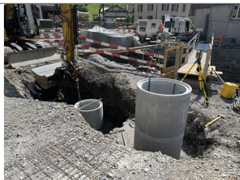
11.08.2025 / Hüribach – Vorbereitung Kranfundamente
