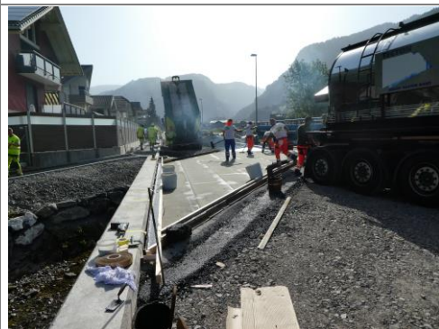
13.08.2025 / Bürgelibach – Einbau Gussasphalt
