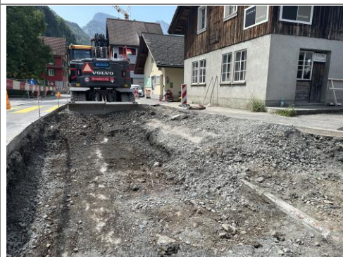
14.08.2025 / Hintere Brücke – Aushub Fundationsschicht
