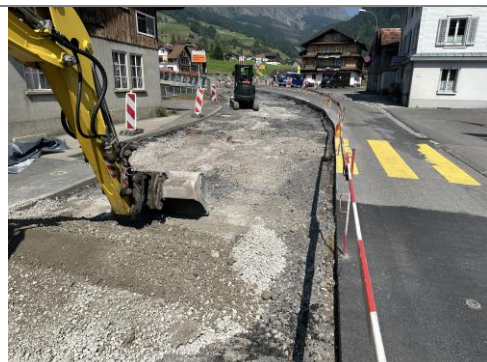
11.08.2025 / Hintere Brücke – Belagsabbruch Fahrspur Schwyz
