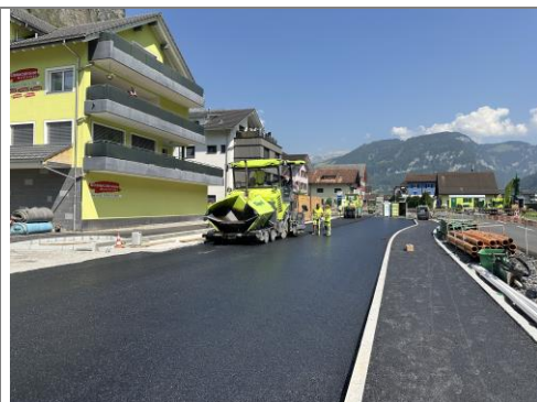
11.08.2025 / Weid-Wegscheide – Einbau Trag- und Binderschicht
