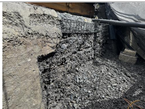
14.08.2025 / Hüribach – HDW-Abtrag rechte Ufermauer
