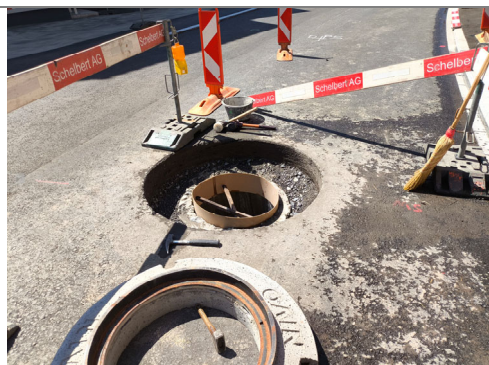
13.08.2026 / Bödeli – Versetzen Schachtabdeckungen
