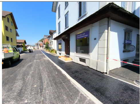
13.08.2026 / Goldplangg-Brämis – Einbau Tragschicht Trottoir
