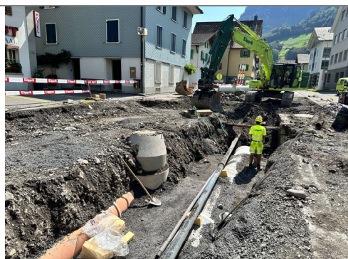
11.08.2026 / Brämis-Poststrasse – Werkleitungsbau WGM/Meteor
