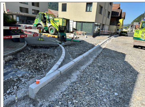
11.08.2026 / Brämis – Versetzen von Randabschlüssen
