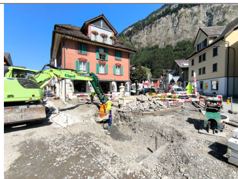
13.08.2026 / Brämis – Versetzen Kontrollschacht WGM
