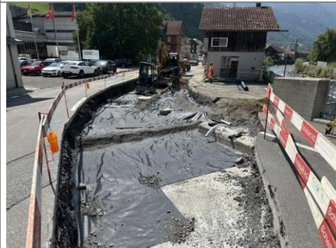
18.08.2025 / Hintere Brücke – Verlegen Geotextil / Werkleitungsbau
