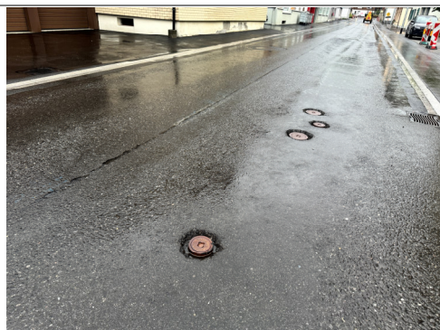
21.08.2026 / Bödeli – Vorbereitungsarbeiten Deckbelageinbau
