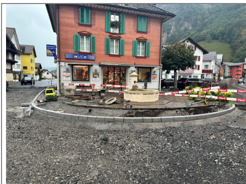
17.08.2026 / Brämis – Versetzen von Randabschlüssen
