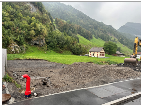
17.08.2026 / Adelmatt – Rückbau Installationsplatz Adelmatt
