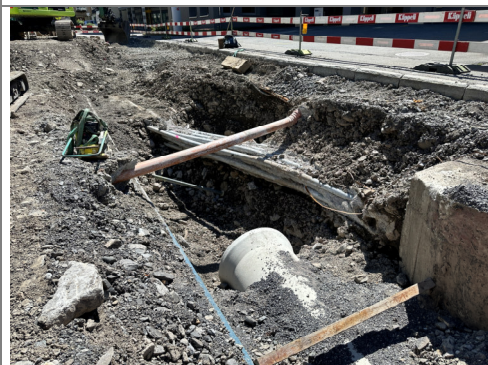
19.08.2026 / Brämis-Poststrasse – Freilegen Swisscomrohrblock
