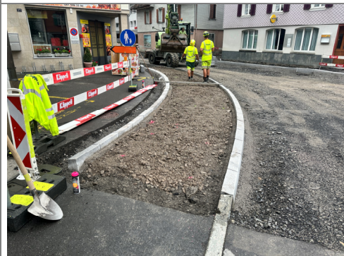
21.08.2026 / Brämis-Poststr. – Einbau Koffer Trottoir
