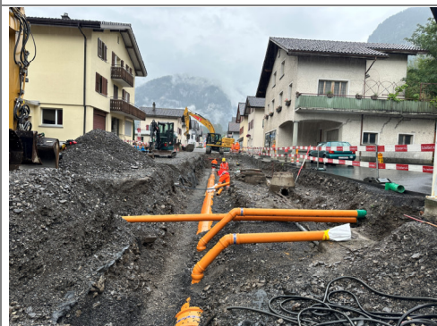
21.08.2026 / Denkmal-Marktstr. – Meteorleitung inkl. Anschlüsse
