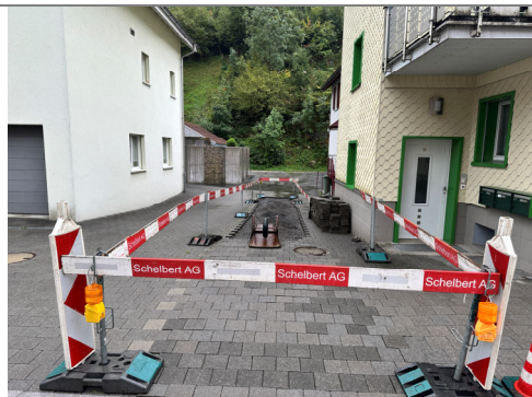
21.08.2026 / Küchenfabrik – Anpassungsarbeiten Vorplätze Privater
