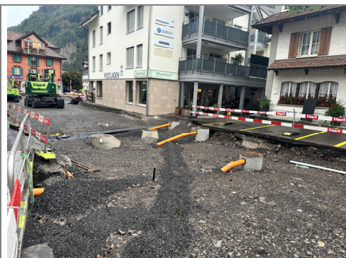
17.08.2026 / Brämis-Poststrasse – Auffüllungen / Einbau Koffer
