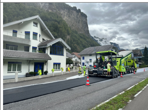
25.08.2026 / Bürgelbach – Einbau Deckbelag FR Schwyz
