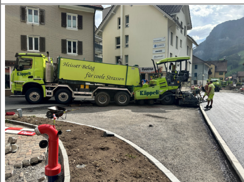
28.08.2026 / Knoten Alpenrösli – Einbau Trag- und Binderschicht
