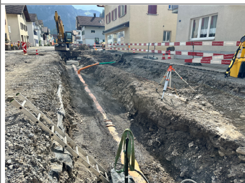
28.08.2026 / Denkmal-Marktstr. – Meteorleitung inkl. Anschlüsse
