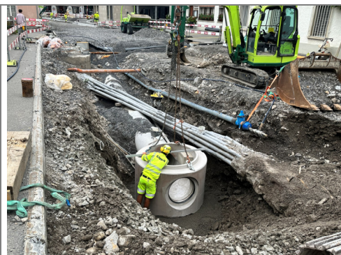
24.08.2026 / Brämis-Poststrasse – Versetzen Kontrollschacht
