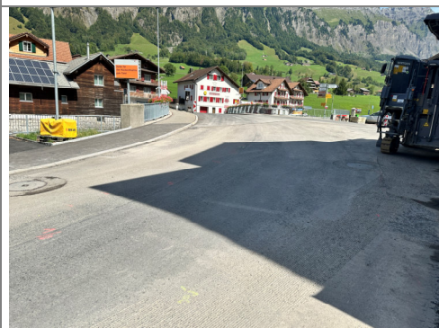
26.08.2026 / Bödeli – Belag fräsen / Vorbereitung Deckbelag
