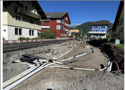
03.09.2025 / Weid-Wegscheide – Verlegen Kabelschutzrohre
