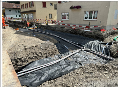
02.09.2026 / Denkmal-Marktstr. – Werkleitungen verlegen / Auffüllung
