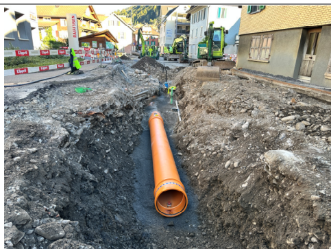
04.09.2026 / Poststr-Holzstr. – Werkleitungsbau Meteorleitung
