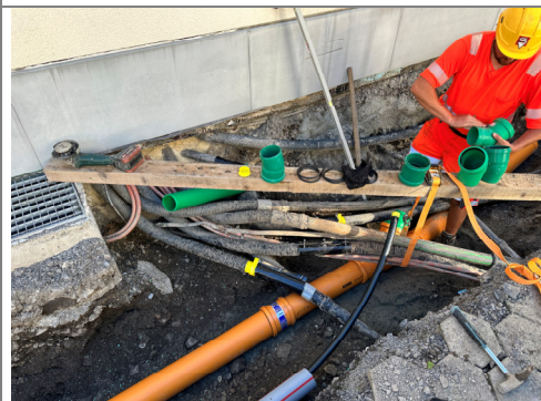
01.09.2026 / Denkmal-Marktstr. – Werkleitungen Hausanschlüsse
