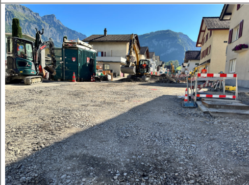
04.09.2026 / Denkmal-Marktstr. – Einbau Koffer / Auffüllungen
