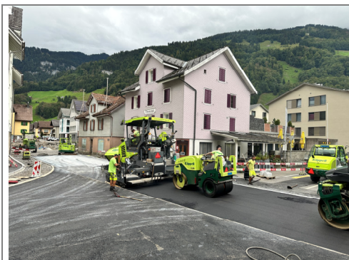
31.08.2026 / Knoten Alpenrösli – Einbau Deckbelag
