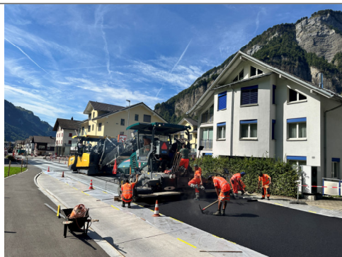
02.09.2026 / Marktstr.-Hintere Brücke – Einbau Deckbelag
