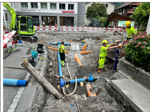
31.08.2026 / Brämis-Poststrasse – Verlegen Trinkwasserleitung
