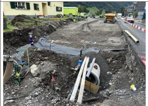
19.09.2025 / Weid-Wegscheide – Werkleitungsbau und Einbau Koffer
