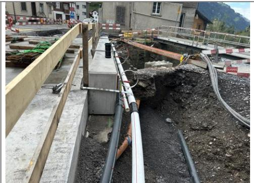
09.09.2025 / Hüribach – Rohrverlegung und Aufhängung an Brücke
