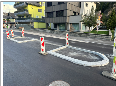
08.09.2026 / Weid – Versetzen Inselsteine Fussgängerquerung
