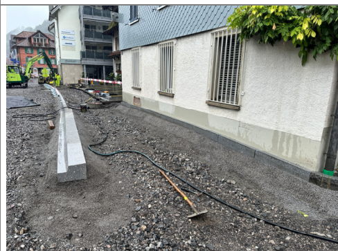
09.09.2026 / Poststr.-Holzstrasse – Versetzen Randabschlüsse
