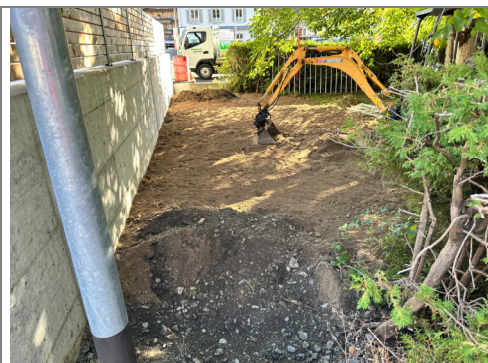
08.09.2026 / Hintere Brücke – Fertigstellungsarbeiten (Gärtner)
