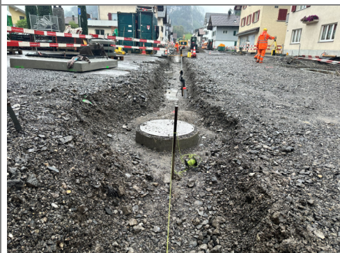
09.09.2026 / Denkmal-Marktstr. – Vorbereitung Versetzen Randabschl.
