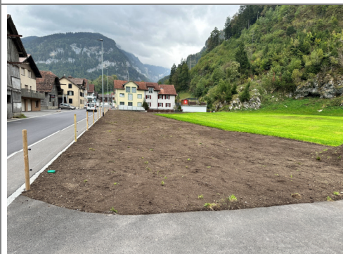
16.09.2026 / Adelmatt – Rückebau Installationsplatz Adelmatt
