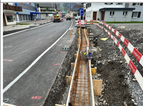
18.09.2026 / Wehri-Denkmalstrasse – Bewehrung Umgebungsmauer
