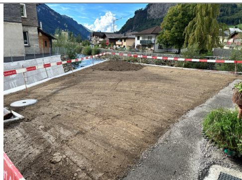
14.09.2026 / Bödeli-Hintere Brücke – Fertigstellungsarbeiten Privater
