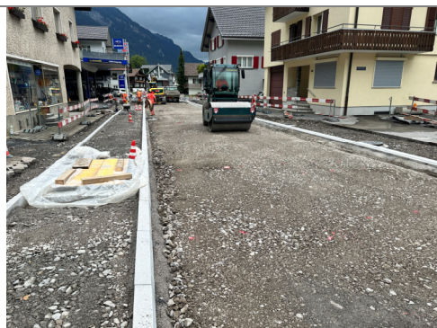
16.09.2026 / Denkmal-Marktstrasse – Rohplanie erstellen
