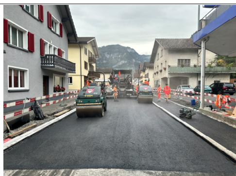
18.09.2026 / Denkmal-Marktstrasse – Einbau Tragschicht Fahrbahn
