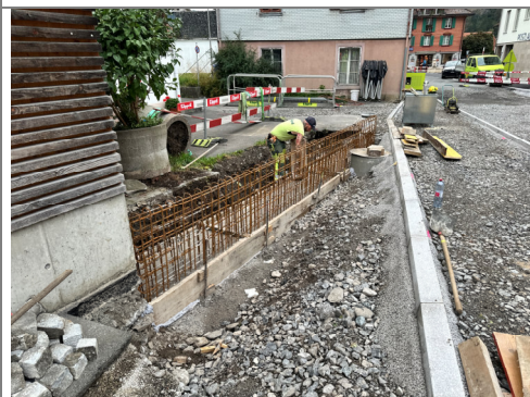
18.09.2026 / Denkmal-Marktstr. – Bewehrung Umgebungsmauer
