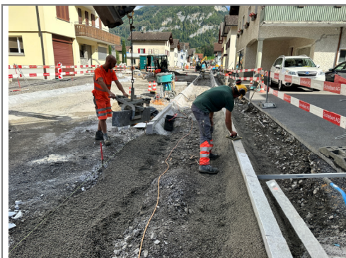
14.09.2026 / Denkmal-Marktstrasse – Versetzen Randabschlüsse
