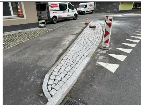
26.09.2025 / Weid – Pflasterung Bankett
