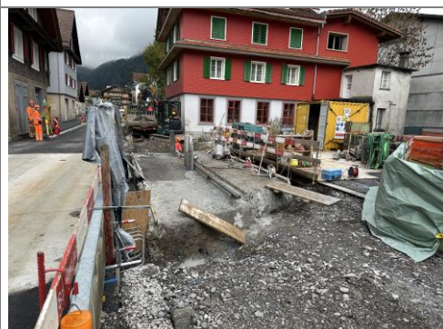
24.09.2025 / Hüribach – Schneiden Brückenplatte
