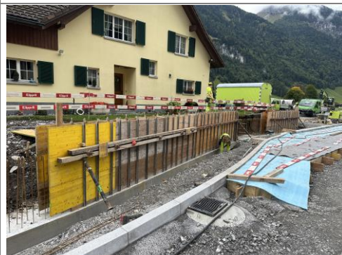
26.09.2025 / Weid-Wegscheide – Schalung und Betonieren Mauer
