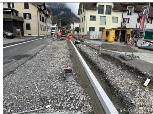
24.09.2025 / Küchenfabrik – Versetzen Randsteine Fahrbahn/Trottoir
