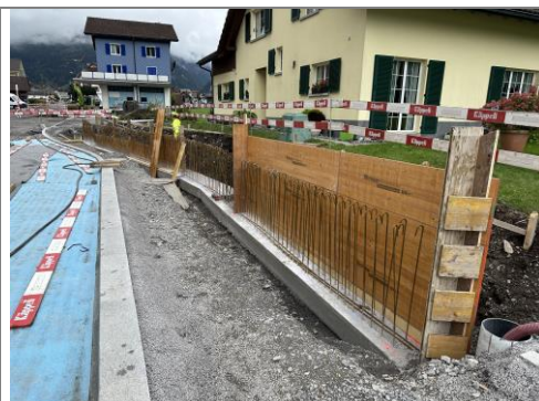
24.09.2025 / Weid-Wegscheide – Schalung Umgebungsmauer 1976
