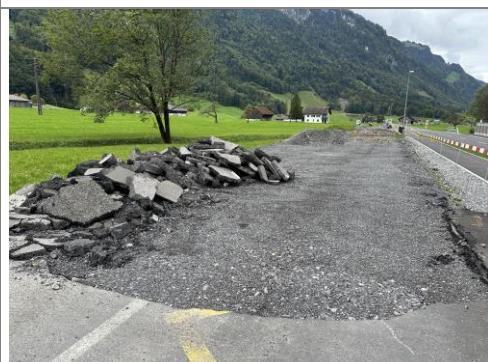
26.09.2025 / Weid – Rückbau provisorische Umfahrung
