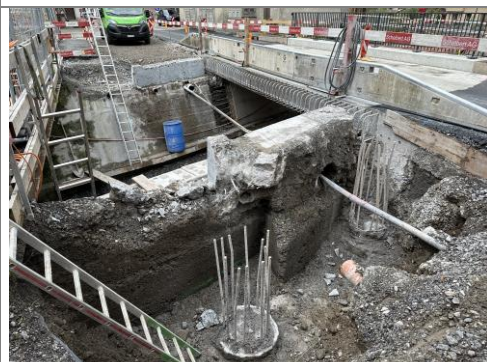
26.09.2025 / Hüribach – Aushub Widerlager / Abbruch Brückenplatte
