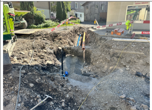
22.09.2026 / Poststr-m 800 – Trink- u. SW-Leitungsanschlüsse
