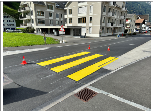
21.09.2026 / ganzer Perimeter – Markierungsarbeiten
