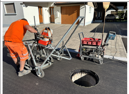
25.09.2026 / Kloster-Denkmalstr. – Abdeckungen auf def. Höhe setzen
