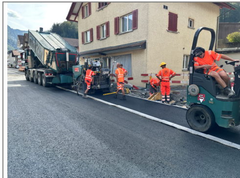
21.09.2026 / Denkmal-Marktstrasse – Einbau Tragschicht Trottoir
