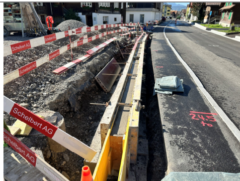
22.09.2026 / Wehri-Denkmalstrasse – Betonieren Umgebungsmauer
