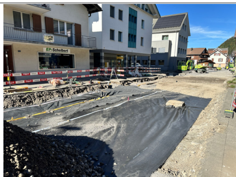
25.09.2026 / Denkmal-Marktstrasse – Einbau Tragschicht Fahrbahn
