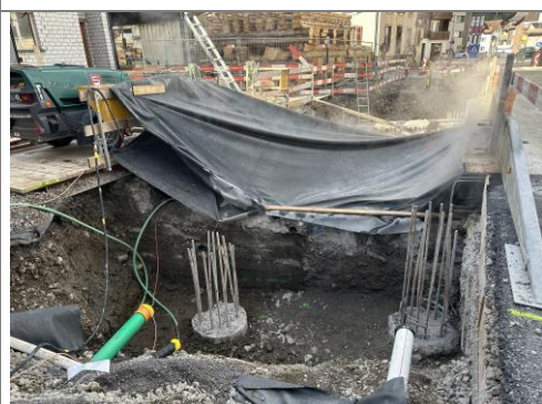
03.10.2025 / Hürbach – Freilegen Pfahlbewehrung / HDW-Abtrag
