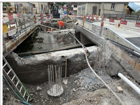
30.09.2025 / Hürbach – Aushub und Abbruch bestehende Brücke
