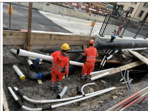
30.09.2025 / Hürbach – Verlegen von Kabelschutzrohren
