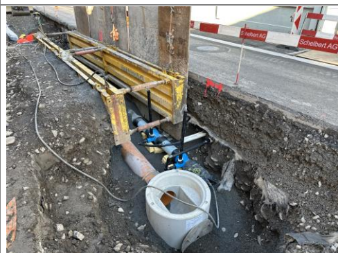
02.10.2025 / Küchenfabrik – Einbau Meteor- und Trinkwasserleitung
