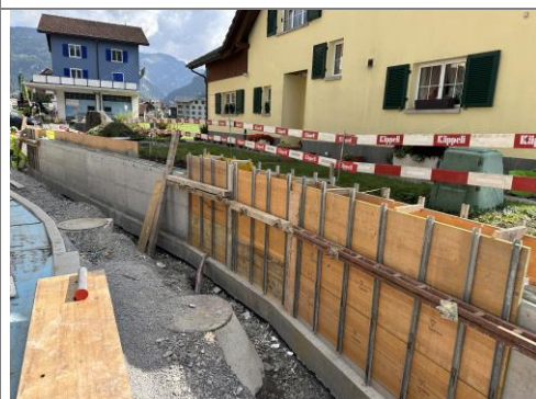
01.10.2025 / Weid – Schalung Umgebungsmauer KTN 1976
