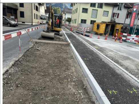
03.10.2025 / Küchenfabrik – Erstellen Rohplanie Fahrbahn + Trottoir
