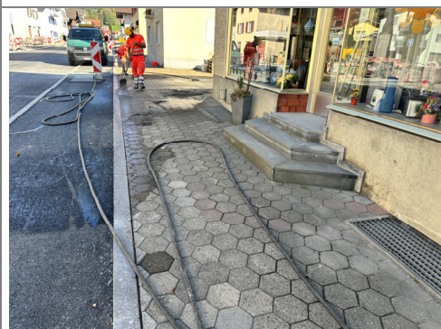
30.09.2026 / Denkmal-Marktstrasse – Fertigstellung Vorplätze Privater
