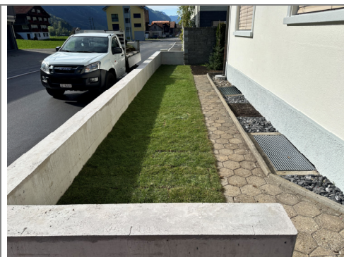
30.09.2026 / Kloster- Denkmalstrasse – Fertigstellung Vorgärten
