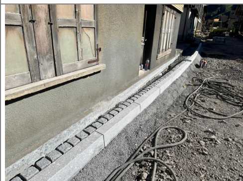
30.09.2026 / Poststr-m 800 – Versetzen Randabschlüsse
