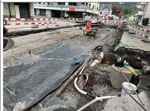
02.10.2026 / Denkmal-Marktstr. – Auffüllungen / Einbau Koffer
