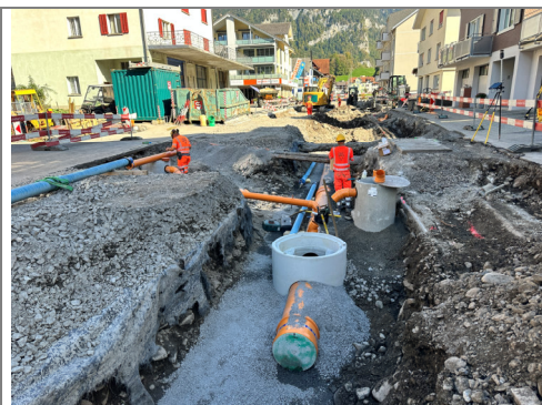
30.09.2026 / Denkmal-Marktstrasse – Werkleitungsbau Meterleitung
