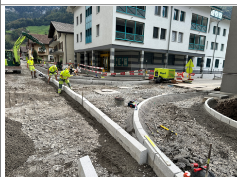
02.10.2026 / Poststr-m 800 – Versetzen Randabschlüsse
