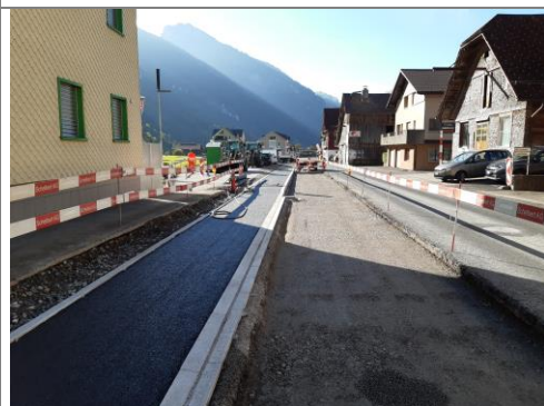
07.10.2025 / Küchenfabrik – Rohplanie Fahrbahn / Belag Trottoir
