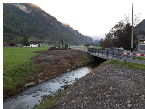
10.10.2025 / Bürgelbach – Rückbau prov. Umfahrung und IP
