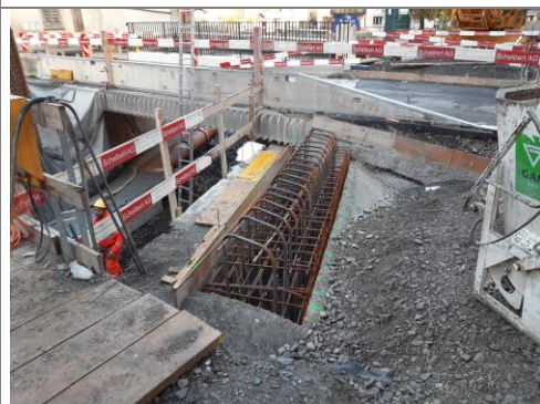
10.10.2025 / Hüribach – Bewehrung Widerlager Seite Hinterthal
