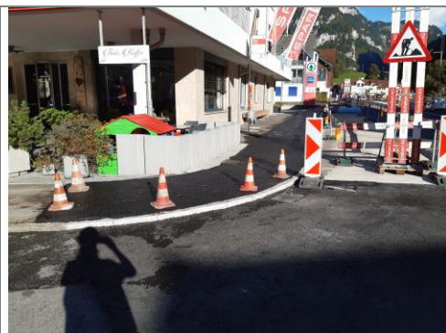
07.10.2025 / Adelmatt – Einbau Deckbelag Trottoir BHS Säge
