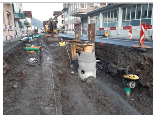
10.10.2025 / Küchenfabrik – Werkleitungsbau inkl. Kontrollschächte
