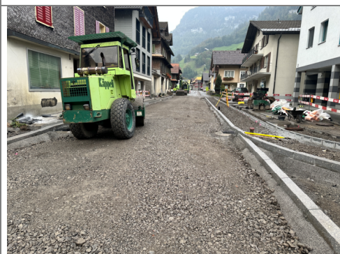
08.10.2026 / Poststr-m 800 – Rohplanie Fahrbahn erstellen
