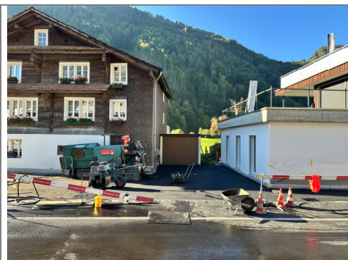
06.10.2026 / Kloster-Denkmalstrasse – Belagseinbau Vorplätze
