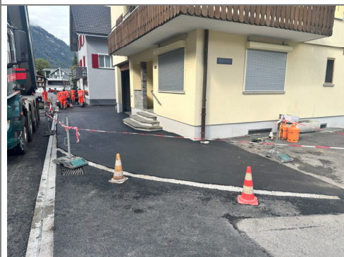
09.10.2026 / Kloster-Denkmalstr. – Einbau Belag Vorplätze Privater
