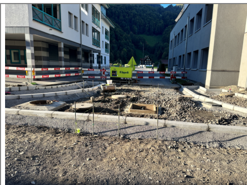
06.10.2026 / Poststr-m 800 – Versetzen & Ausfugen Randabschlüsse
