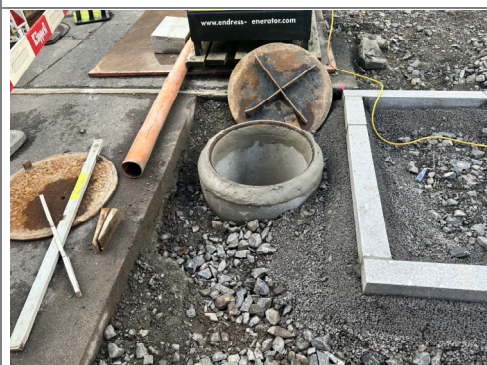
09.10.2026 / Poststr.-m 800 – Kontrollschächte versetzen
