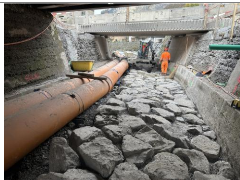
16.10.2025 / Hüribach – Erstellen Blockrampe Sohle
