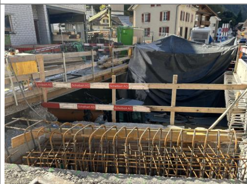
13.10.2025 / Hüribach – Bewehrung Widerlager / HDW-Abtrag Mauer
