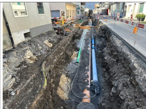
13.10.2025 / Küchenfabrik – Verlegen Meteor- / Trinkwasserleitung
