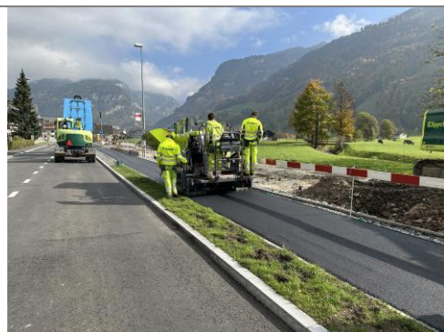
17.10.2025 / Weid – Einbau Deckbelag Rad-/Gehweg
