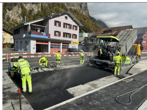
15.10.2025 / Weid-Wegscheide – Einbau Tragschicht Fahrbahn
