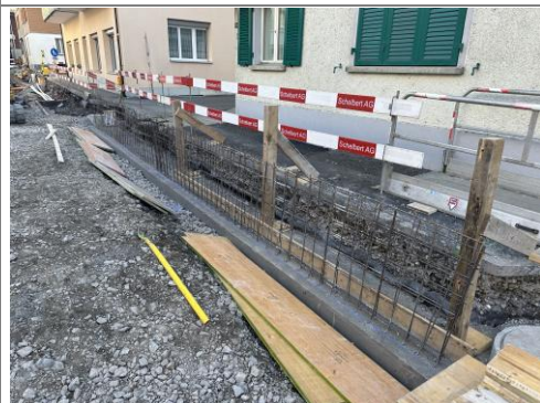
15.10.2025 / Küchenfabrik – Fundament Umgebungsmauer KTN 1211
