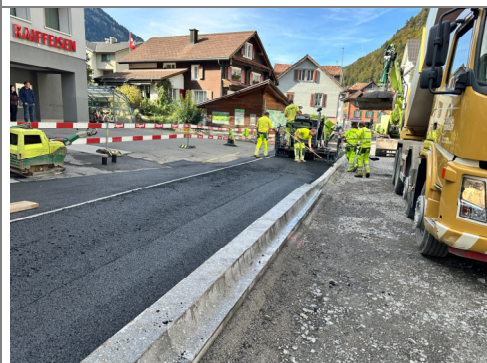
15.10.2026 / Poststr-m 800 – Einbau Tragschicht Trottoir
