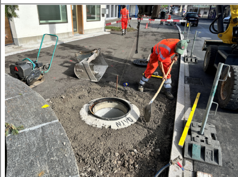
15.10.2026 / Kloster-Denkmalstrasse – Anpassungsarbeiten Vorplätze
