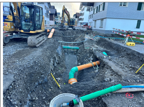
12.10.2026 / Denkmal-Marktstrasse – Provisorische Anschlüsse
