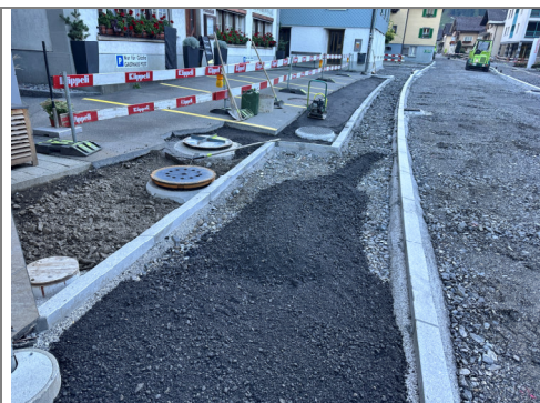
12.10.2026 / Poststr-m 800 – Planearbeiten Vorplätze und Trottoir
