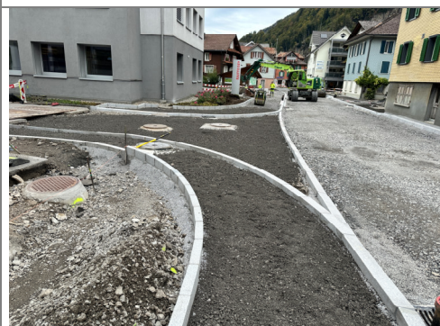
13.10.2026 / Poststr-m 800 – Planearbeiten Einlenker und Trottoir
