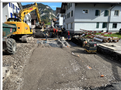
15.10.2026 / Denkmal-Marktstrasse – Einbau Koffer / Werkleitungsbau
