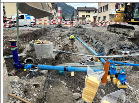
13.10.2026 / Denkmal-Marktstrasse – Trinkwasserleitung inkl. Hydrant
