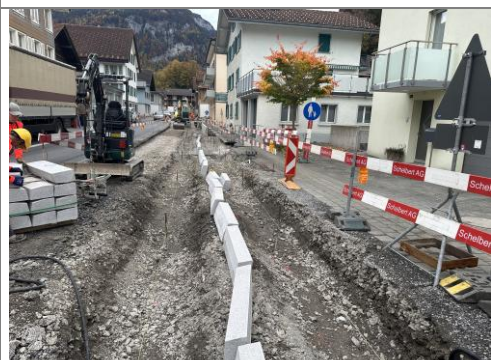
21.10.2025 / Küchenfabrik – Versetzen Randabschlüsse
