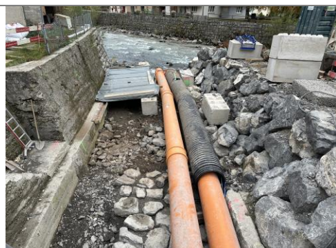
21.10.2025 / Hüribach – Umlegen Wasserhaltung / Blocksatz
