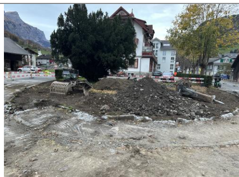
21.10.2025 / Wegscheide – Hecken roden / Abbrucharbeiten
