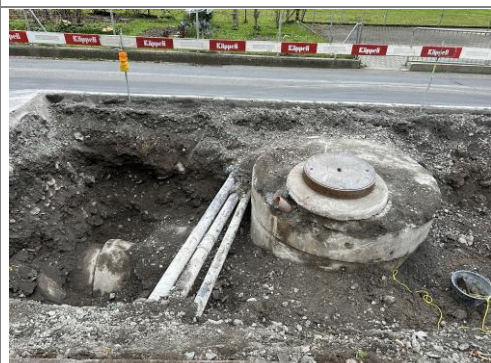
21.10.2025 / Wegscheide – Sondage Kontrollschacht und Leitungen
