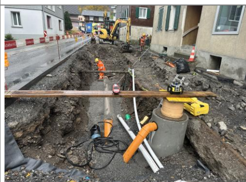
23.10.2025 / Küchenfabrik – Werkleitungsbau / Schlamm-sammler
