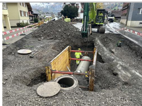
22.10.2025 / Wegscheide – Verlegen Schmutzwasserleitung
