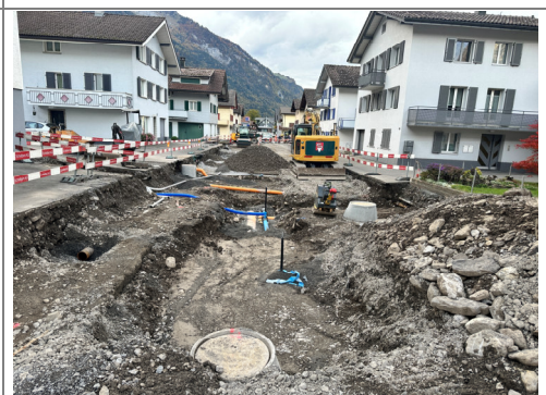
23.10.2026 / Denkmal-Marktstrasse – Einbau Koffer / Werkleitungsbau
