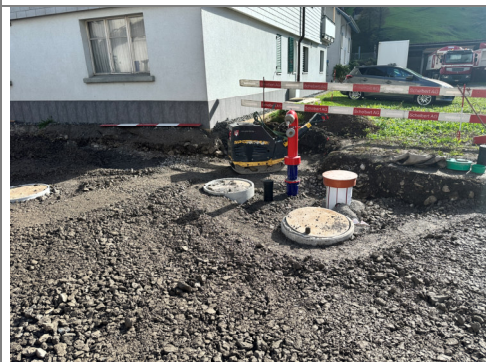
19.10.2026 / Denkmal-Marktstrasse – Auffüllungen Werkleitungsbau
