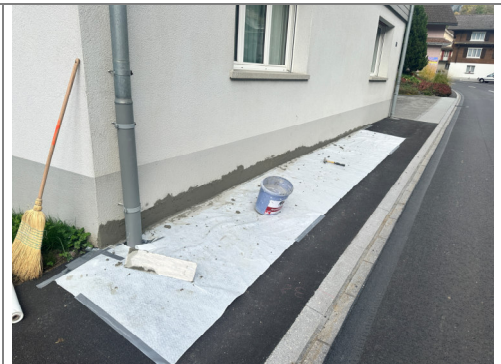
19.10.2026 / Bödeli – Instandsetzungsarbeiten Fassaden
