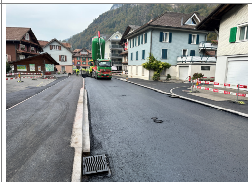
20.10.2026 / Poststr-m 800 – Einbau Binderschicht Fahrbahn
