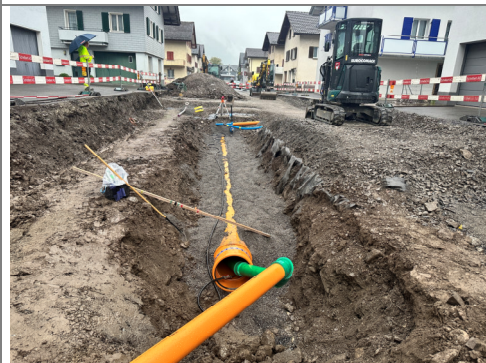
21.10.2026 / Denkmal-Marktstrasse – Verlegen Meteorleitung
