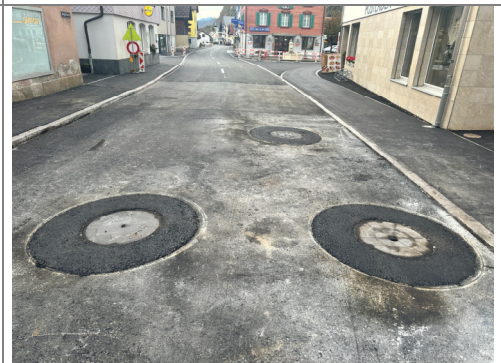
23.10.2026 / Poststr-m 800 – Höhersetzen von Schachtabdeckungen
