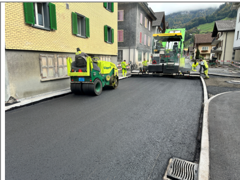
19.10.2026 / Poststr-m 800 – Einbau Tragschicht Fahrbahn
