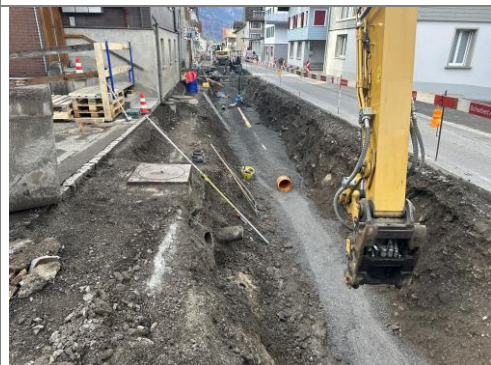
28.10.2025 / Küchenfabrik – Aushub und Verlegen Meteorleitung
