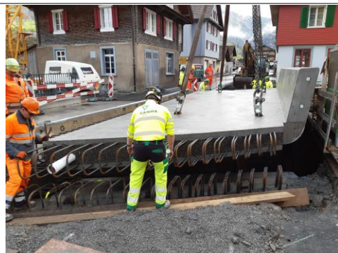
30.10.2025 / Hüribach – Versetzen Brückenplatte 3
