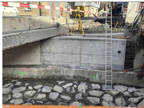
29.10.2025 / Hüribach – Vorbereitung Versetzen Brückenplatte
