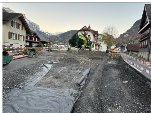
28.10.2025 / Wegscheide – Aushub- und Koffersersatz
