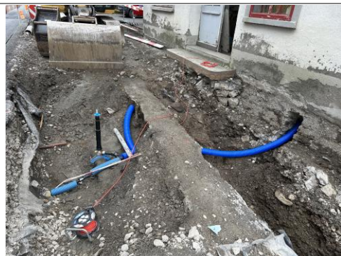
30.10.2025 / Hintere Brücke – Verlegen Trinkwasseranschluss
