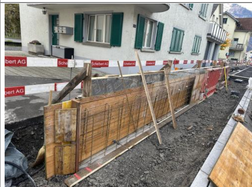
29.10.2025 / Küchenfabrik – Schalung und Bewehrung Mauer
