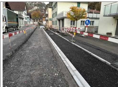
28.10.2025 / Küchenfabrik – Versetzen Randabschlüsse/Planie
