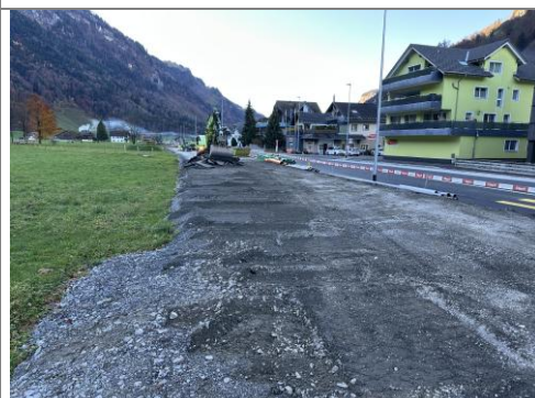
03.11.2025 – Rückbau prov. Umfahrung und Installationsplatz
