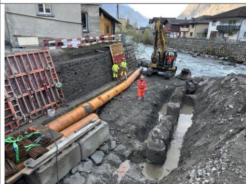
07.11.2025 / Hüribach – Schalung Ufermauer
