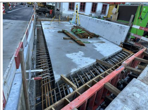
03.11.2025 / Hüribach – Bewehrung Schlaufstoss
