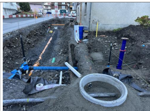
03.11.2025 / Küchenfabrik – Verlegen div. Werkleitungen u. Schächte
