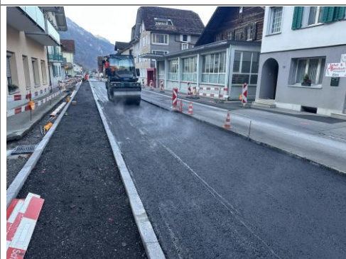
05.11.2025 / Küchenfabrik – Einbau Tragschicht
