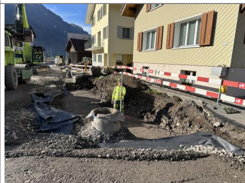
07.11.2025 / Wegscheide – Abbruch und Aushub Umgebungsmauer
