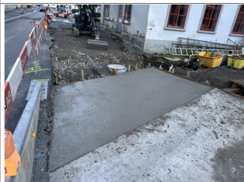
07.11.2025 / Hüribach – Betonieren Schleppplatten FR Hinterthal
