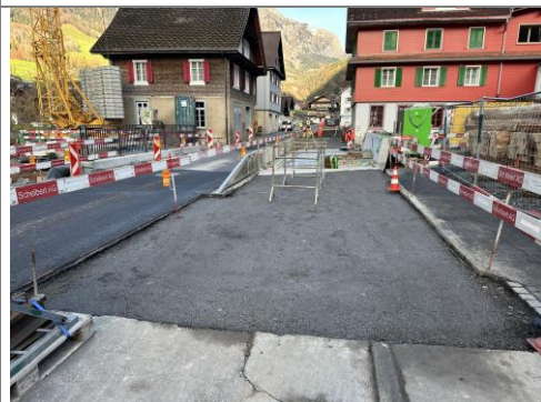
11.11.2025 – Hüribach – Einbau Koffer / Erstellen Planie
