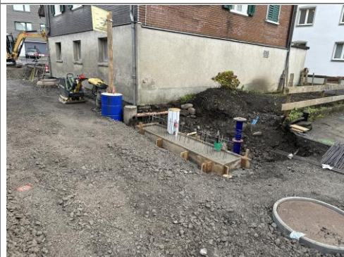
12.11.2025 / Küchenfabrik – Fundament Umgebungsmauer KTN 533
