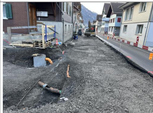
11.11.2025 – Küchenfabrik – Einbau Koffer / Fertigstellung Werkleitung
