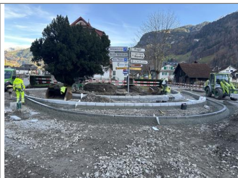
11.11.2025 / Wegscheide – Versetzen Randabschlüsse
