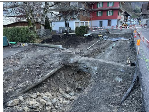
12.11.2025 / Hintere Brücke – Aushub und Werkleitungsbau
