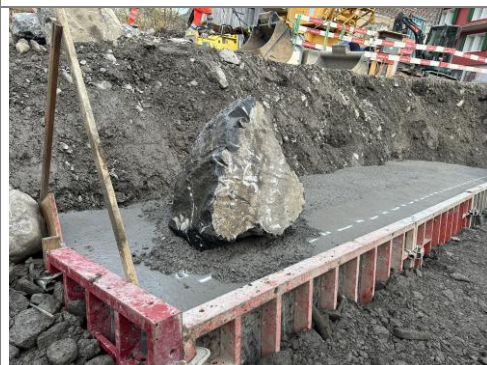
12.11.2025 / Hüribach – Versetzen Blocksteine rechte Uferseite
