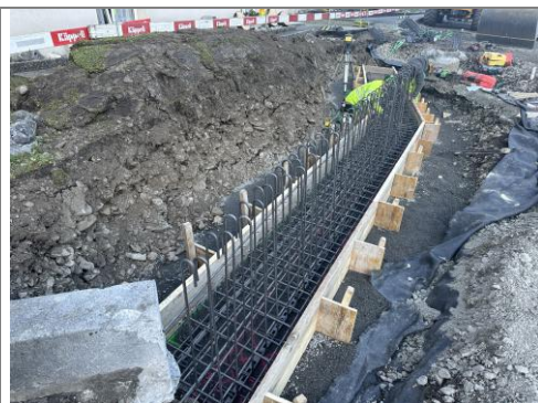
11.11.2025 / Wegscheide – Bewehrung Fundament KTN 1217
