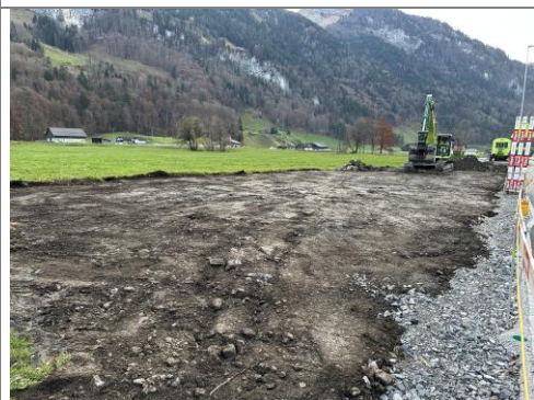
12.11.2025 / Weid – Rückbau Installationsplatz
