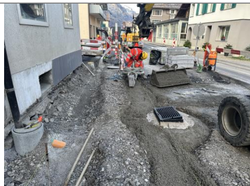
19.11.2025 / Küchenfabrik – Versetzen Randabschlüsse
