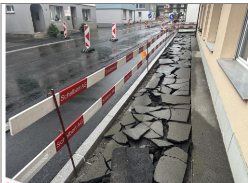
17.11.2025 / Küchenfabrik – Belagsabbruch Vorplätze
