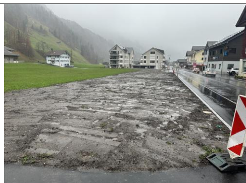
17.11.2025 / Adelmatt – Rückbau und Humusierung prov. Trasse
