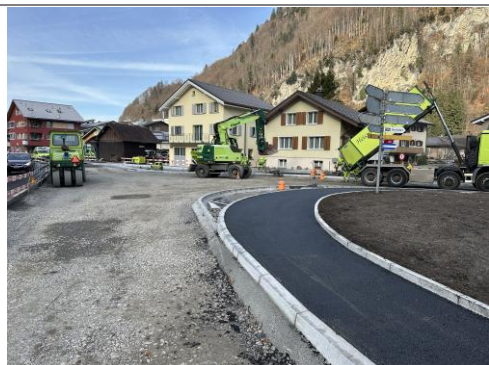
19.11.2025 / Wegscheide – Einbau Tragschicht Trottoir
