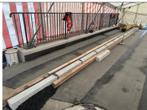
20.11.2025 / Hüribach – Kleben Randsteine und PBD-Abdichtung
