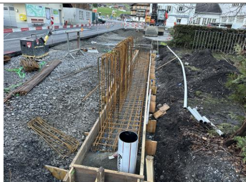
18.11.2025 / Hintere Brücke – Bewehrung Umgebungsmauer KTN 91
