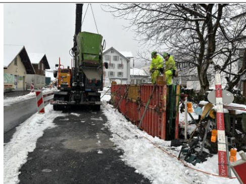
26.11.2025 / Hintere Brücke – Betonieren Umgebungsmauer KTN 91
