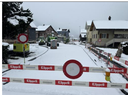
26.11.2025 / Wegscheide – Teileinstellung Baustelle (Schneefall)
