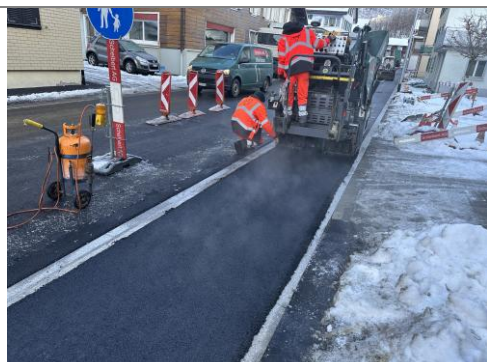
28.11.2025 / Küchenfabrik – Einbau Deckbelag Trottoir
