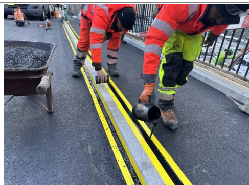
28.11.2025 / Hüribach – Vergiessen Heissvergussfugen
