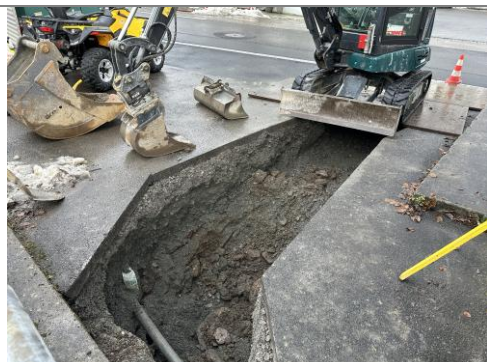
25.11.2025 / Hintere Brücke – Querableitung Meteorleitung
