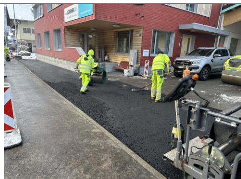
28.11.2025 / Wegscheide – Einbau Tragschicht Vorplatz KTN 629
